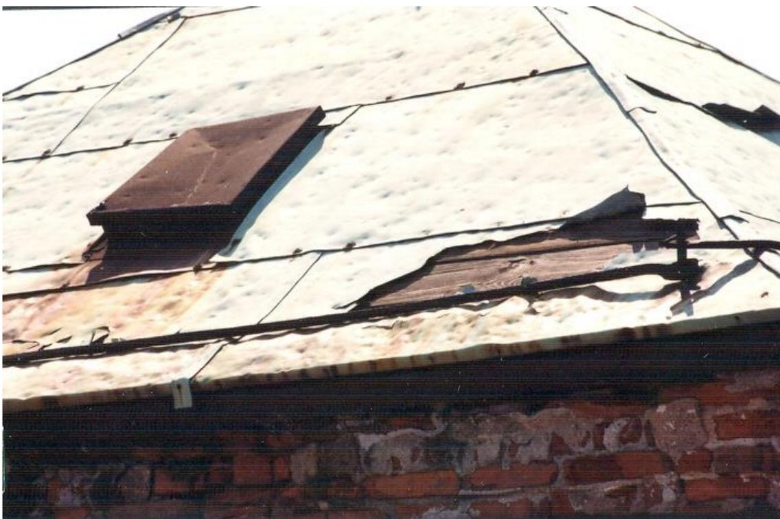
Campanile nord, lato ovest, copertura. È evidente lo stato della copertura in spesse lastre di rame. Letteralmente strappate dal vento, che a questo livello (il duomo è collocato su un rilievo dallo sbocco della valle di Aosta) è violentissimo. Si notano i passi d'uomo per l'ispezione e le barre ferma neve.
