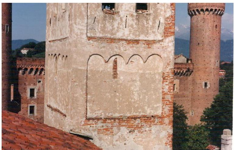
Campanile nord, lato est, quinto livello. Costituisce la ripresa costruttiva, ancora nell'ambito del cantiere preromanico dopo l'arresto e la formazione del tetto provvisorio. Qui gli archetti pensili hanno ancora il passo ampio di quelli sottostanti. È caratterizzato da una bifora completamente tamponata.
