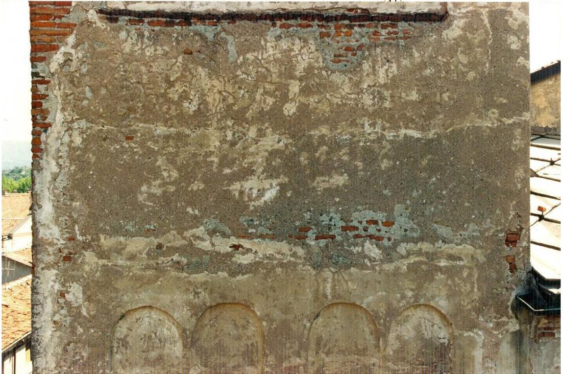
Campanile nord, lato ovest, quarto livello. Piano cieco. L'intonaco nasconde, nella parte inferiore, la cornice scalpellata che testimonia l'arresto costruttivo, con la formazione di un tetto provvisorio.
