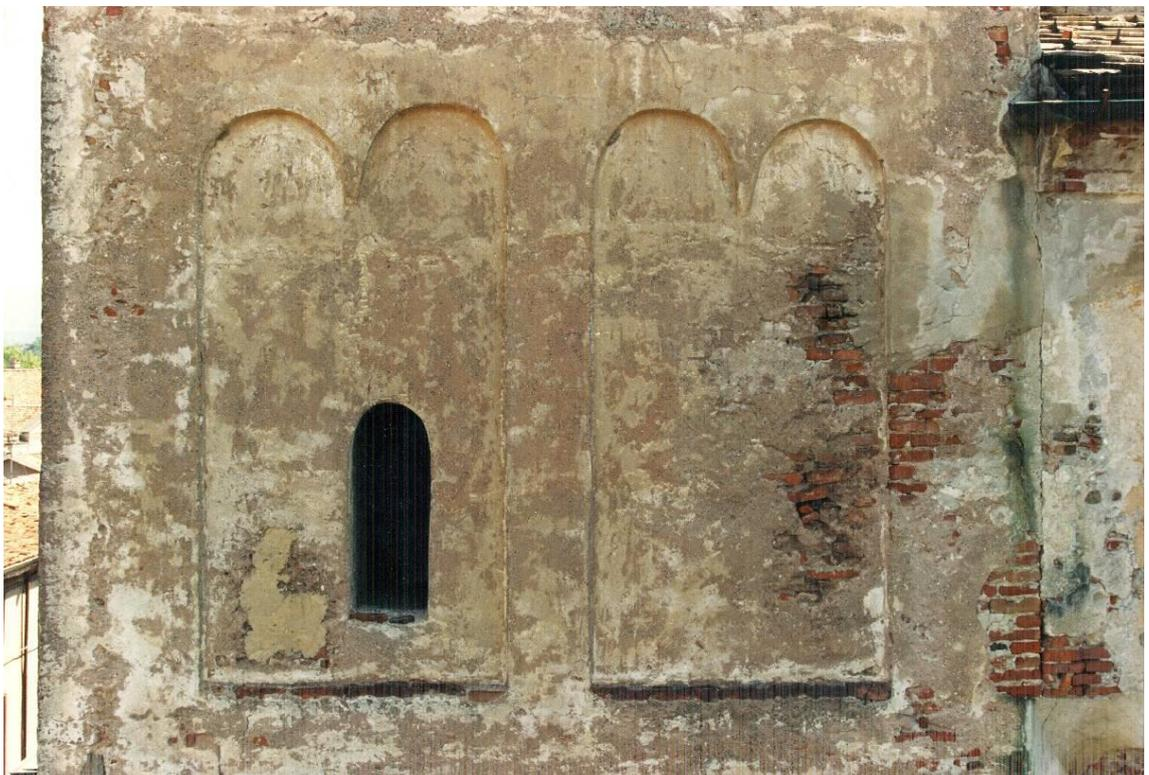
Campanile nord, lato ovest, terzo livello. Due campi conclusi da archetti binati, uno dei quali caratterizzato da una piccola monofora. A destra connessione con l'abside, o meglio con il tamponamento che occlude lo stacco fra il campanile e la curva absidale.
