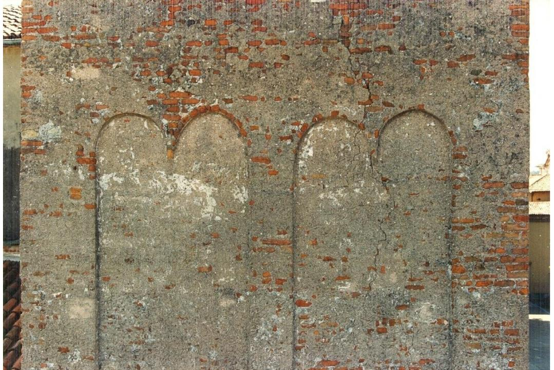
Campanile nord, lato nord, terzo livello. Con i livelli sottostanti, costituisce una prima fase preromanica, che si conclude temporaneamente a questo livello, per motivi sconosciuti, con la realizzazione di una copertura provvisoria in corrispondenza del piano cieco superiore. È caratterizzato da due campi, separati da una lesena, privi di aperture e conclusi da grandi archetti pensili binati, con un passo di 75 cm circa.
