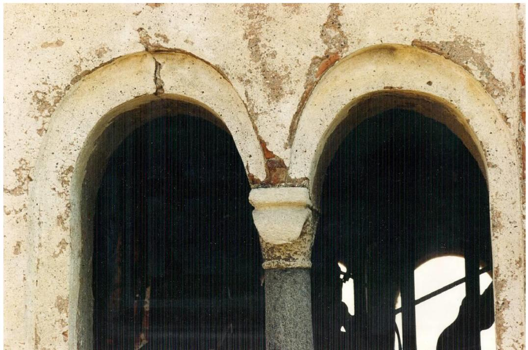
Campanile nord, lato ovest, settimo livello. Particolare della bifora di sinistra. Contrariamente alla parte preromanica, dove colonnine e capitelli sono variamente arrangiati con materiale di recupero, nei due piani della ricostruzione romanica questi elementi architettonici sono eseguiti appositamente.
