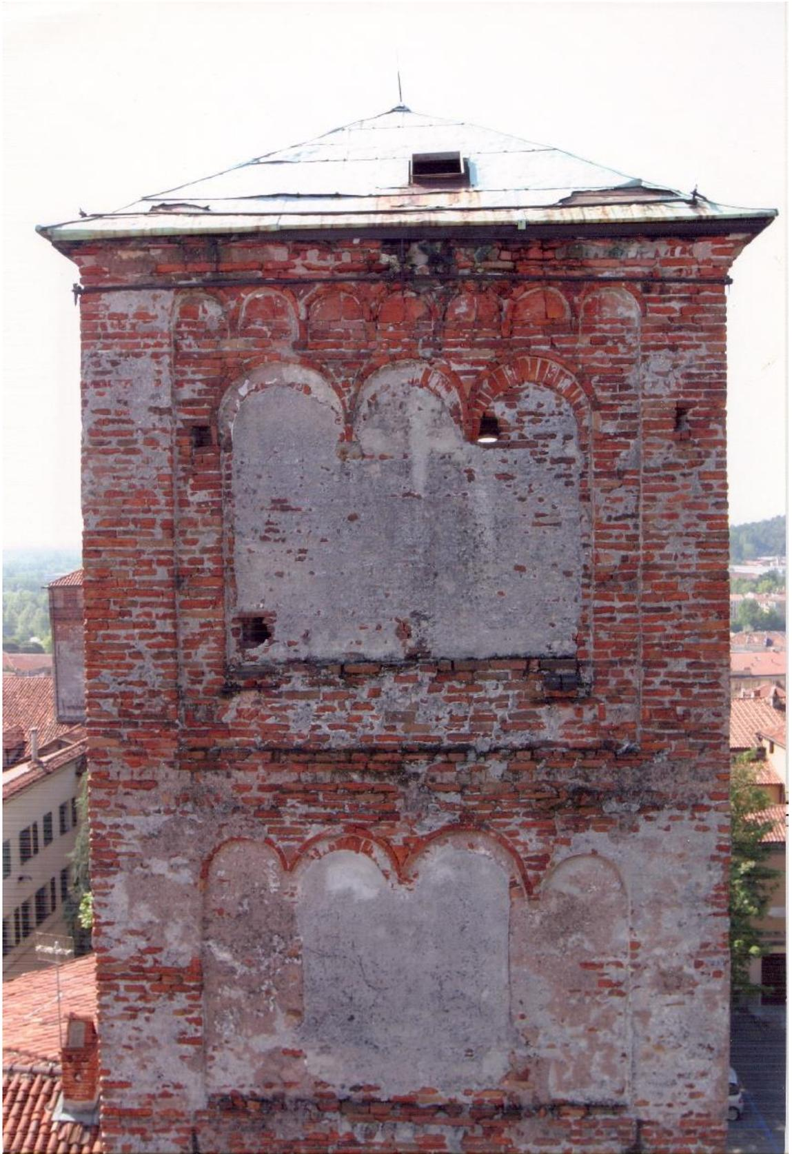
Campanile sud, lato nord. Sesto e settimo livello con la bifora e la trifora tamponate. Si può notare il pessimo stato della copertura.
