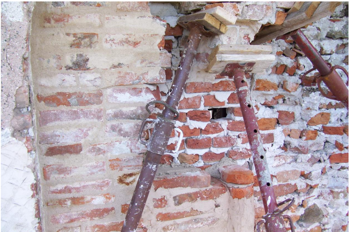
Sesto livello, lato nord. ricostruzione dell'arco di sinistra e integrazione dell'arco centrale della trifora.
