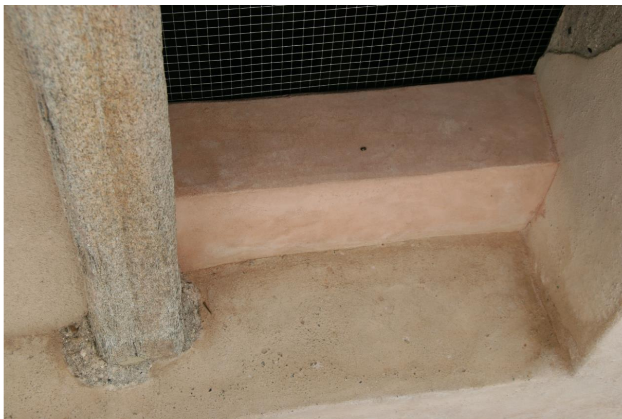
Sesto livello, particolare del davanzale di una trifora.
