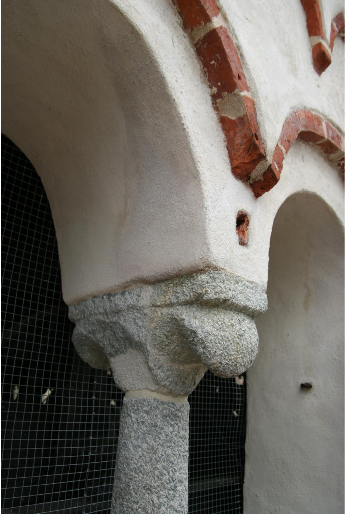
Il capitello a restauro ultimato. Con la ricostruzione dell'imposta degli archi non si è ricostruita la mensolina alla base delle cigliature delle ghiere.
