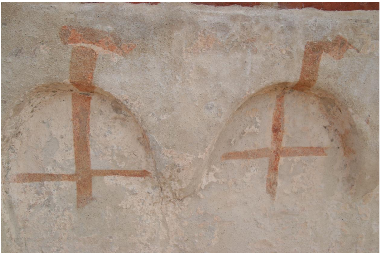
Recupero delle pitture che interessano gli archetti.
