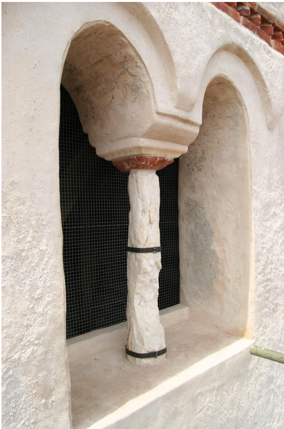
Quinto livello, lato est. La bifora completamente restaurata.
