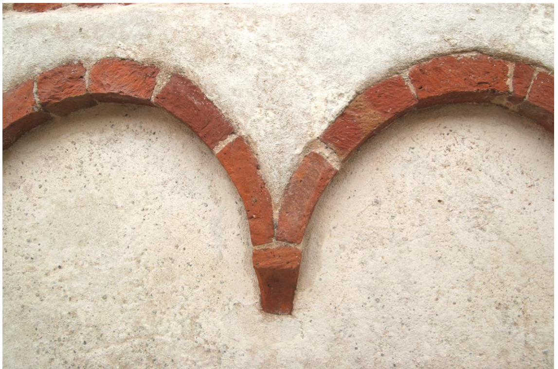
Dettagli del recupero degli archetti pensili: scoprimento e risarcimento dei giunti, aspetto finale.
