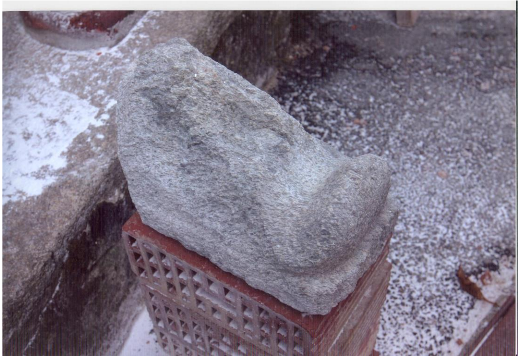
Frammento del capitello originale, ritrovato nel muretto di rialzamento del davanzale. È stato completato con la ricostruzione della parte simmetrica mancante.
