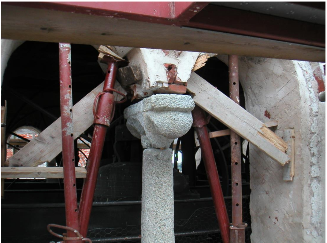
Rimessa in opera del capitello ricostruito, con la parte originale in vista, previo puntellamento degli archi.
