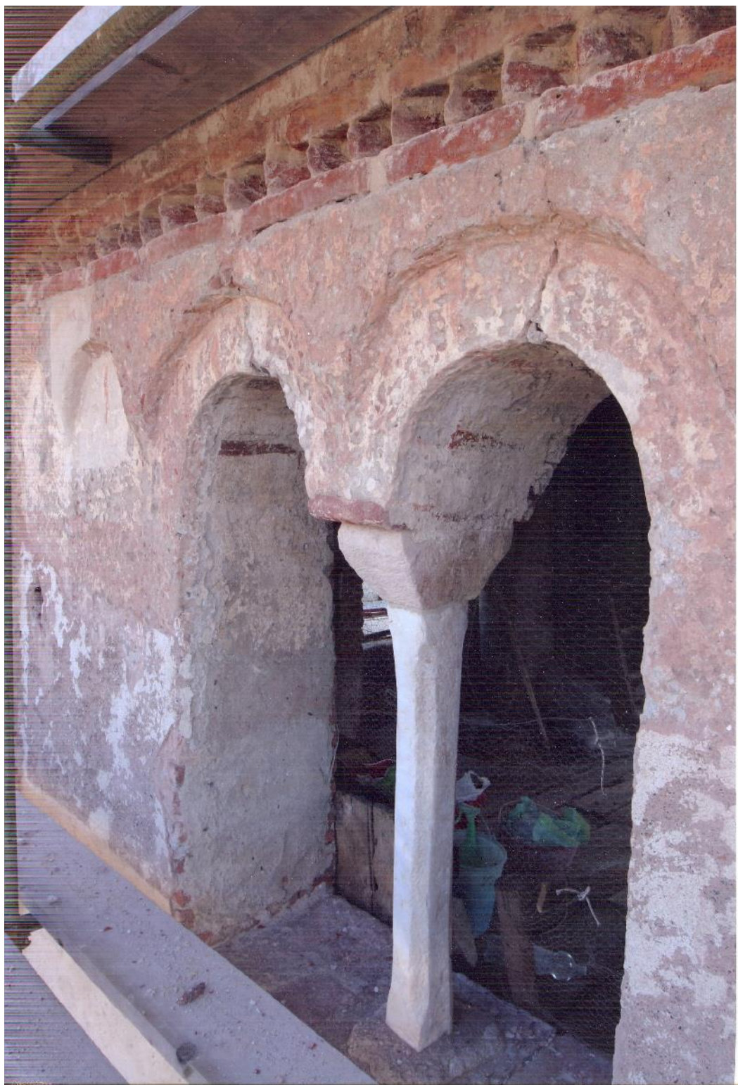
Quinto livello, lato ovest. La bifora, appena stamponata, rivela segni di pittura.
