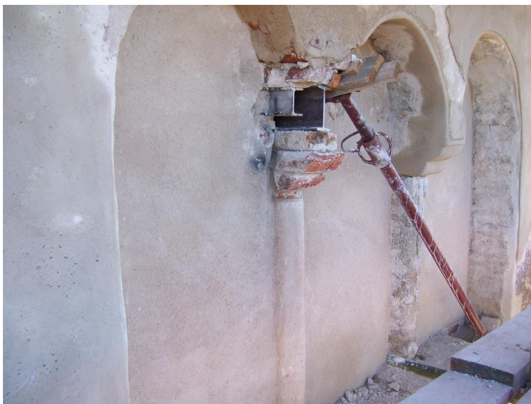
Sesto livello, lato nord. ricostruzione dell'imposta e del capitello di sinistra della trifora.
