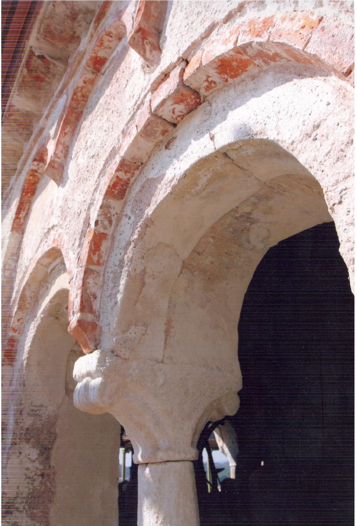
Settimo livello, lato est, bifora di destra.
