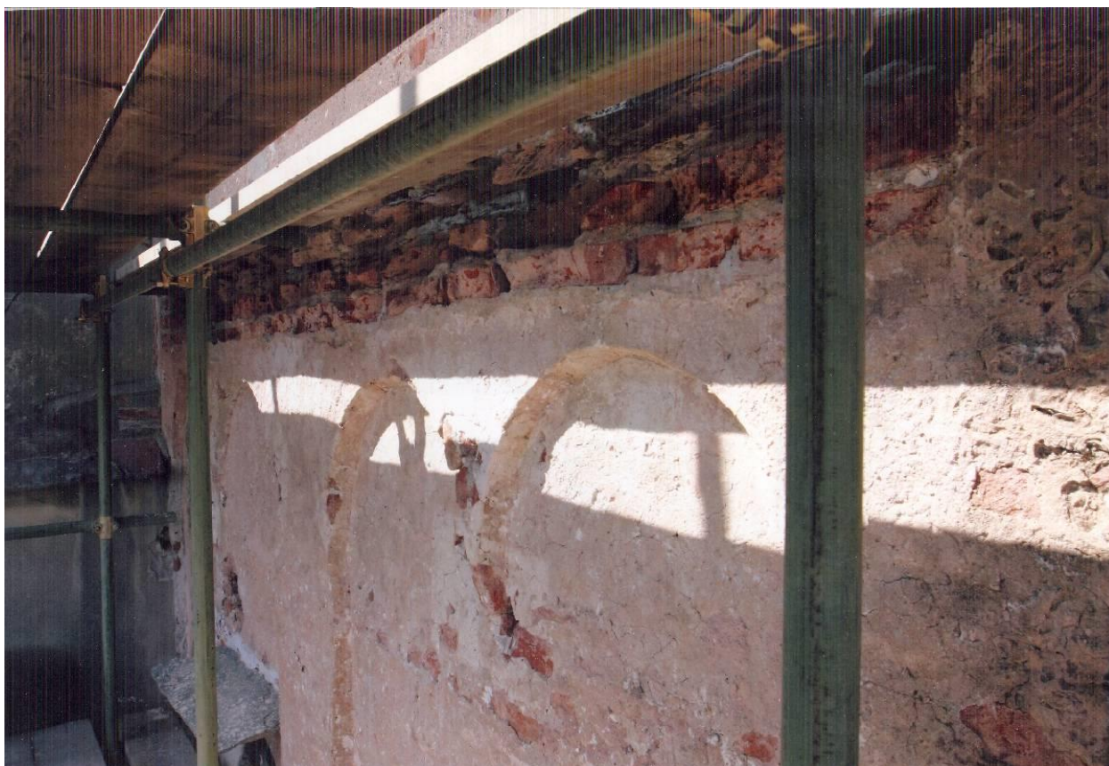
Quarto livello, lato est. I resti della cornice del tetto provvisorio, che interessano i lati est e ovest.
