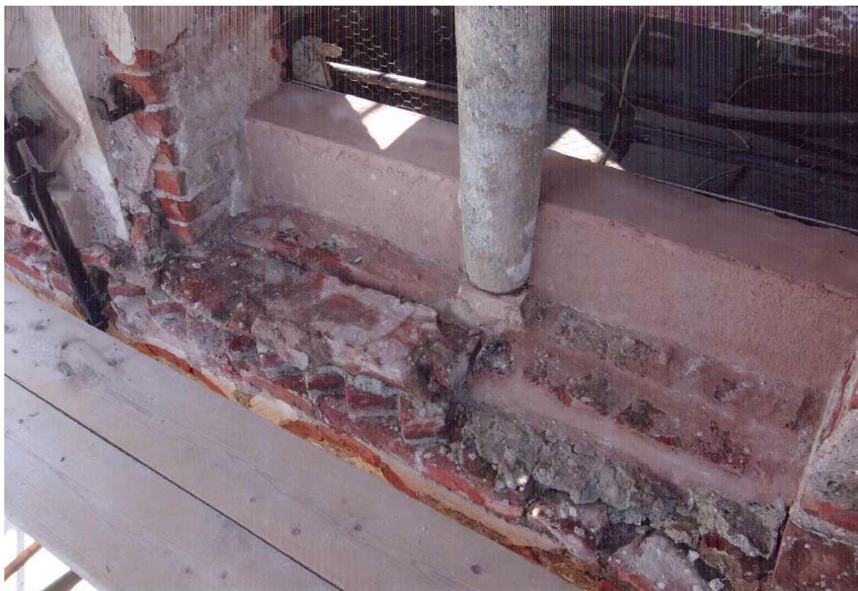
Settimo livello, lato est, particolare dell'immagine precedente.
