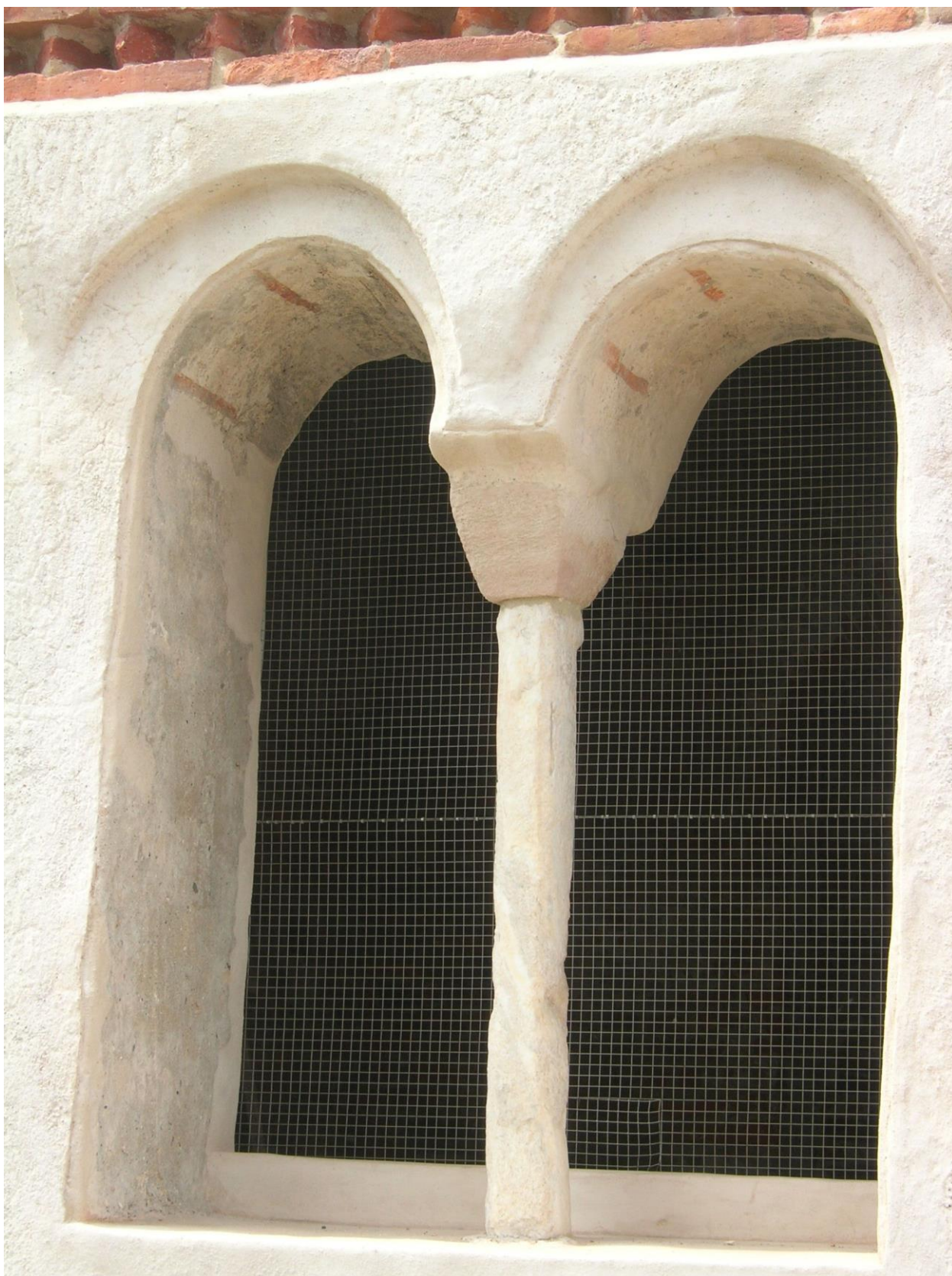
Quinto livello, lato sud. La bifora restaurata. Tracce di pittura recuperate nei sottarchi.
