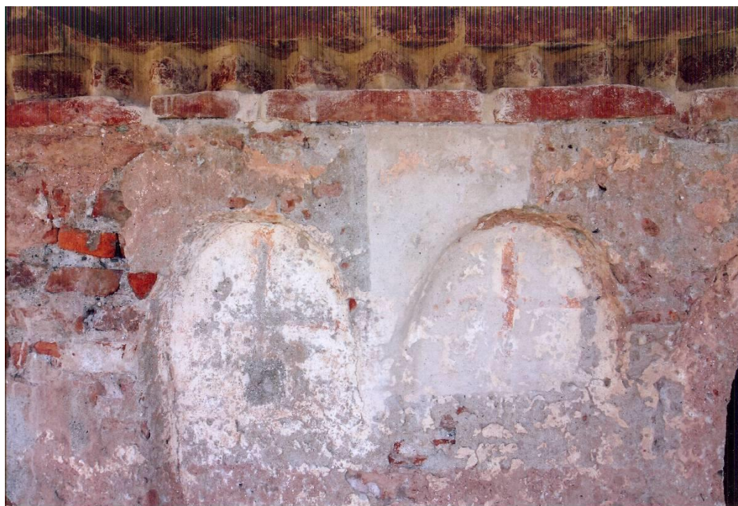
Una fase dello scoprimento.
