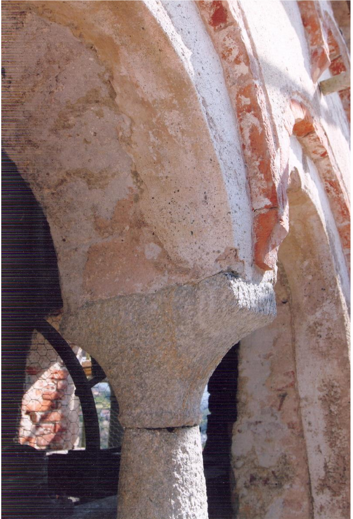
Settimo livello, lato sud. Le cigliature delle ghiere in laterizi di recupero sagomati, destinati a restare in vista, si impostano su mensoline in corrispondenza dei capitelli.
