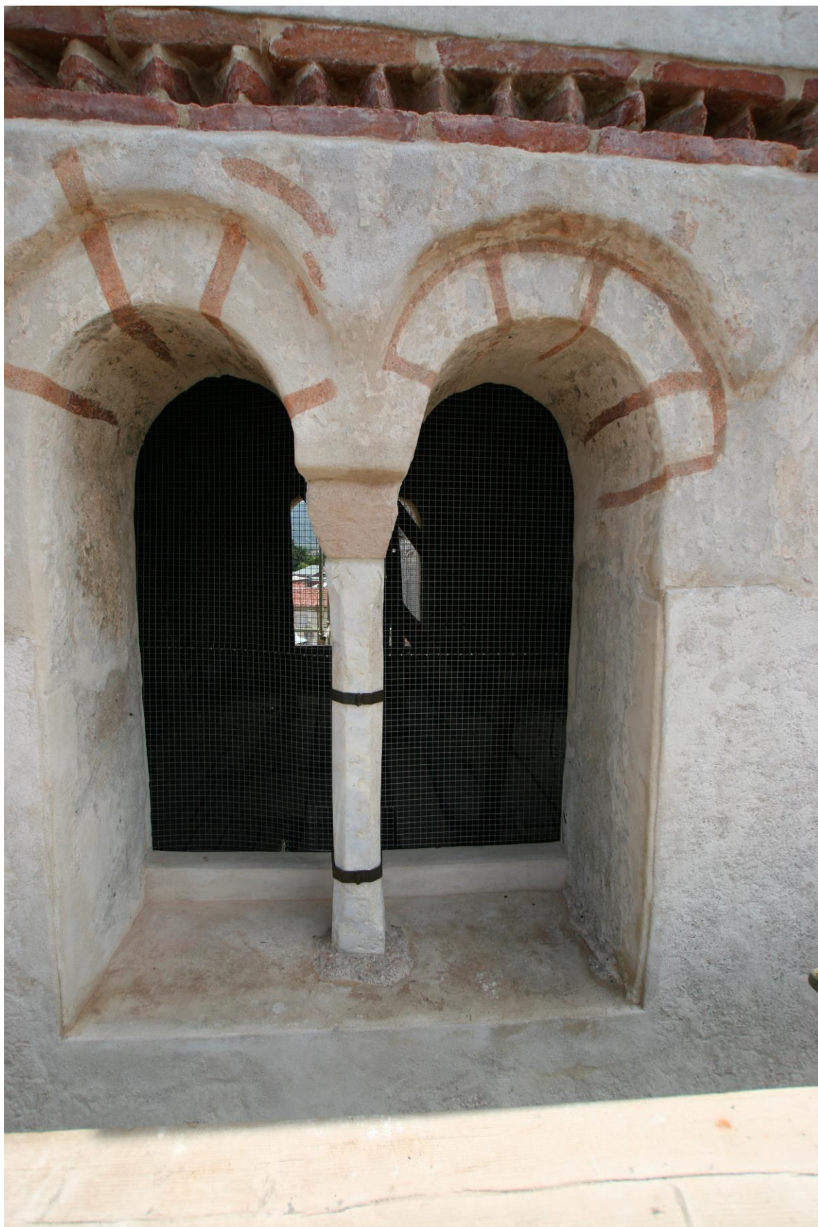
Quinto livello, lato ovest. La bifora, restaurata, con le tracce di pittura recuperate.
