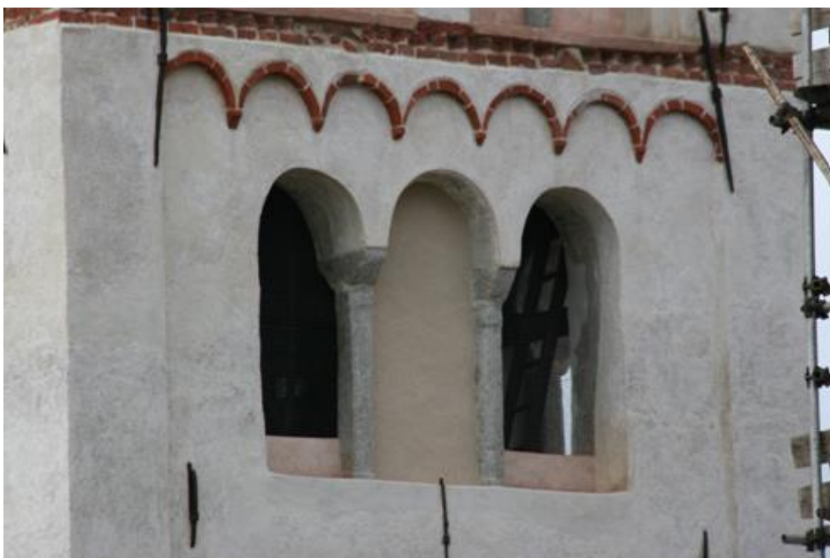
Sesto livello, lato sud. Due immagini della trifora a lavori conclusi.
