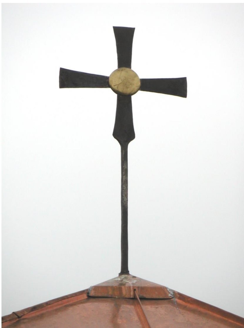
La ricollocazione della croce sul campanile nord
