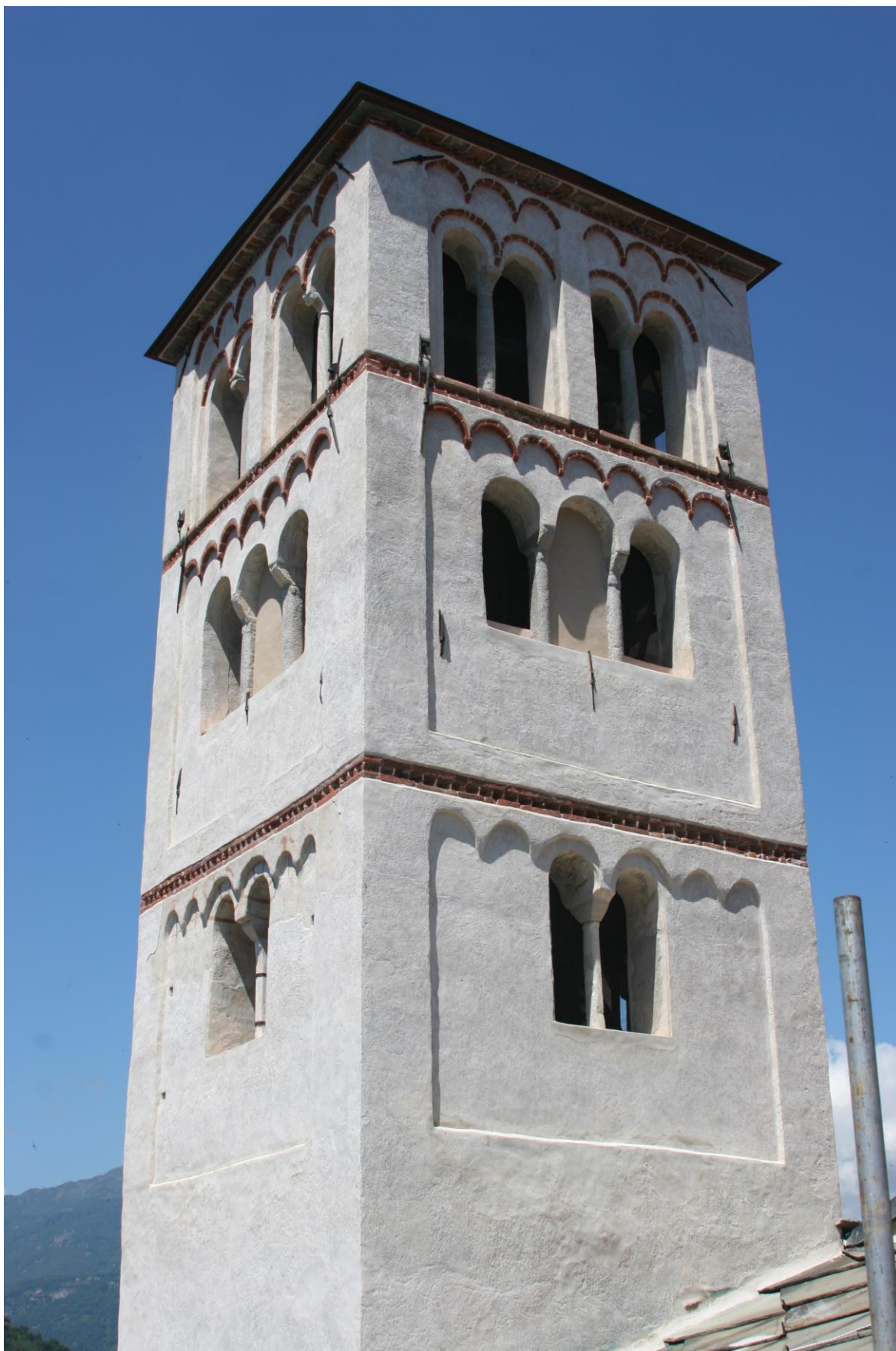
Il campanile nord, restaurato, subito dopo lo smontaggio dei ponteggi.
