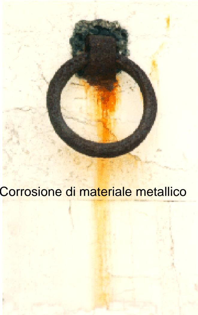
Corrosione di materiale metallico
